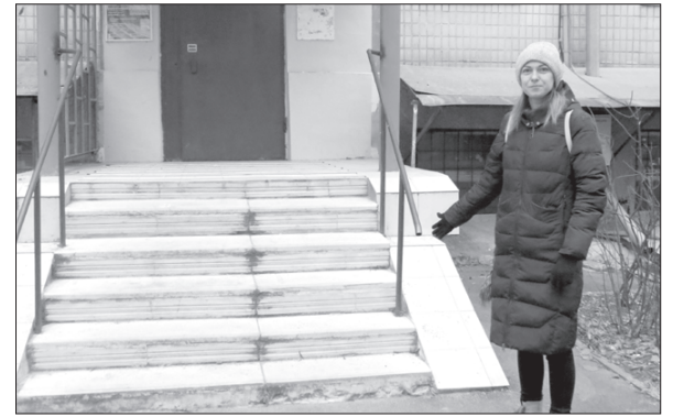
Відремонтували сходи у всіх під'їздах. Демонструє керівник ОСББ Юлія Ільшова
