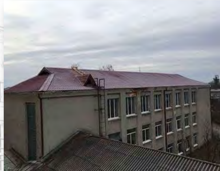
Реконструкція покрівлі СЗШ І-ІІІ ст.№1 смт Крижопіль
