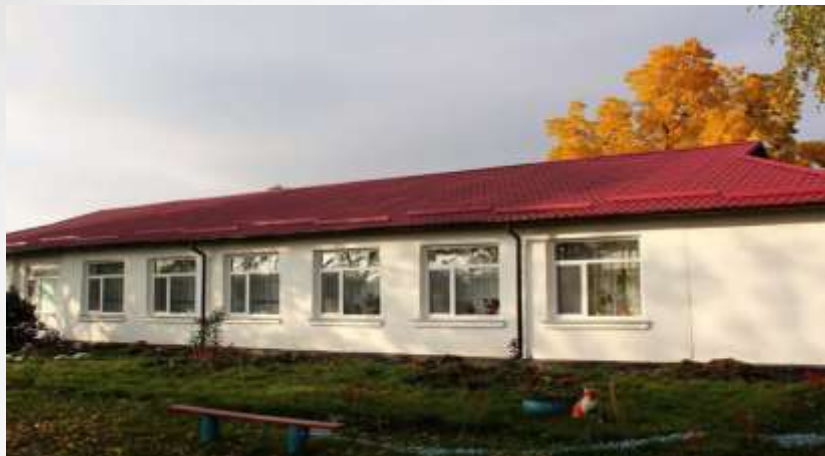
Заміна даху та утеплення ДНЗ № 4 "Малютко" м. Іллінці
