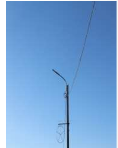
Ремонт мережі вуличного освітлення с.Тягун та с. Володимирівка Іллінецької ОТГ
