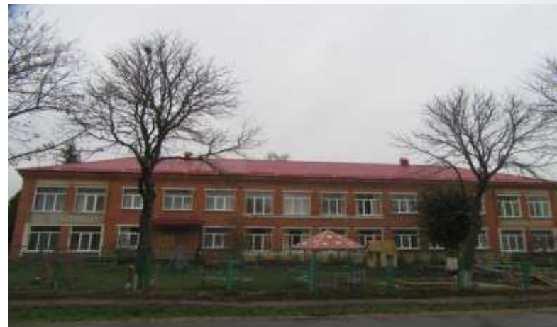
Заміна даху та утеплення в ДНЗ № 1 "Сонечко" м.Іллінці
